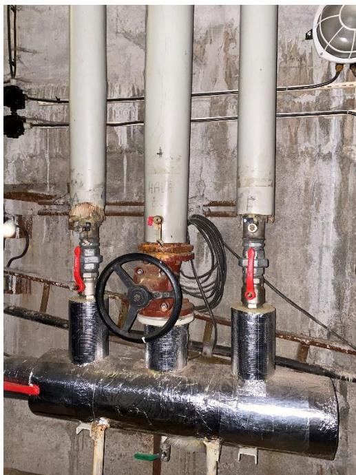
Obr. č. 10 – Rozdělovač teplé vody a cirkulace v Univerzitě
