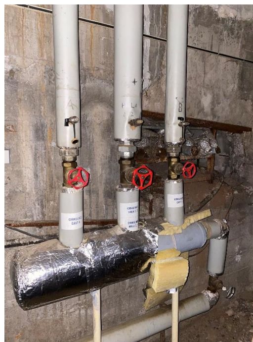
Obr. č. 10 – Rozdělovač teplé vody a cirkulace v Univerzitě
