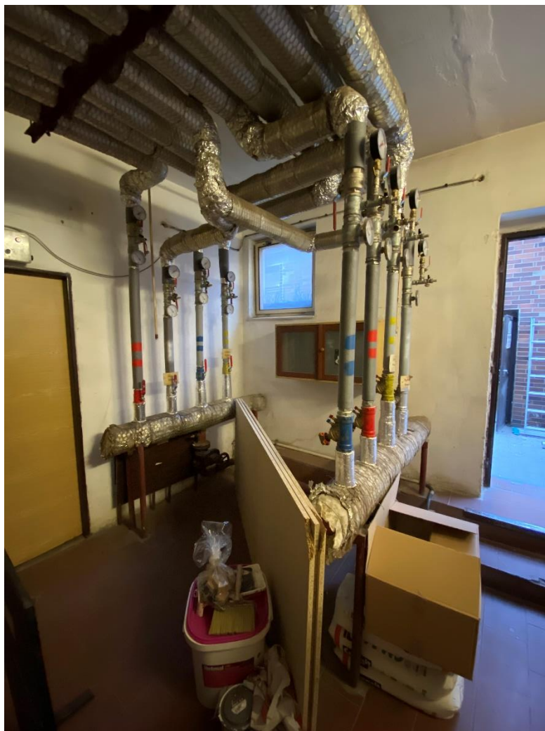
Obr. č. 7 – Podružný rozdělovač / sběrač topné vody TVJ
