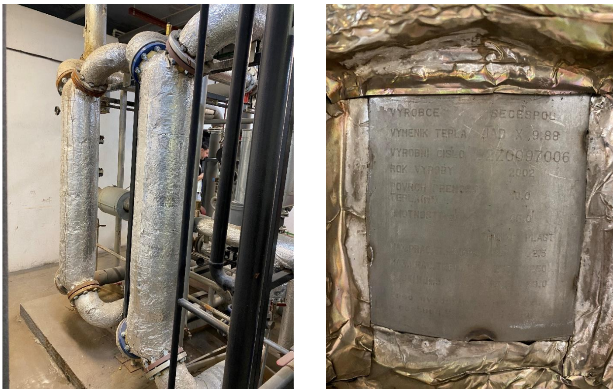
Obr. č. 5 –Hlavní VS - Výměníky pára-voda
