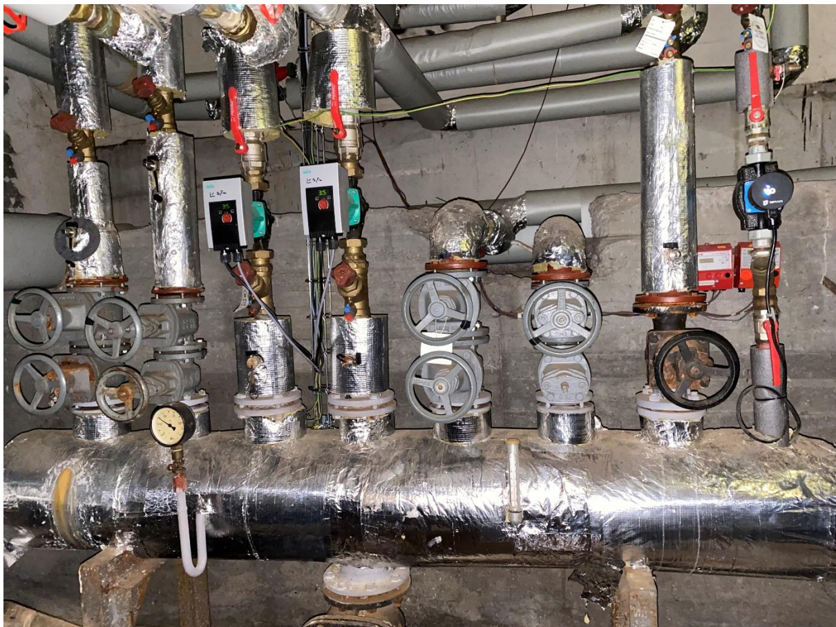
Obr. č. 9 – Rozdělovač topné vody v Univerzitě
