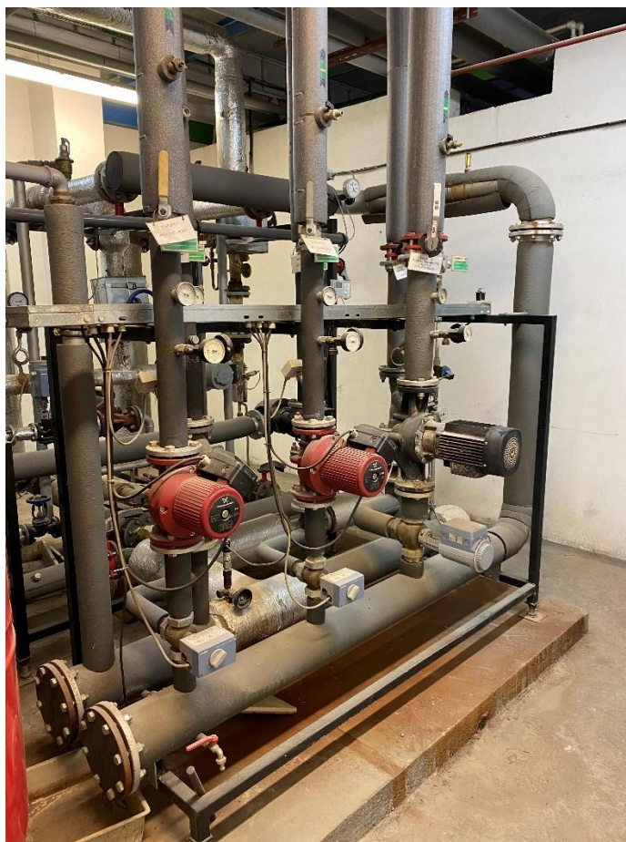
Obr. č. 6 – Hlavní VS - Rozdělovač topné vody
