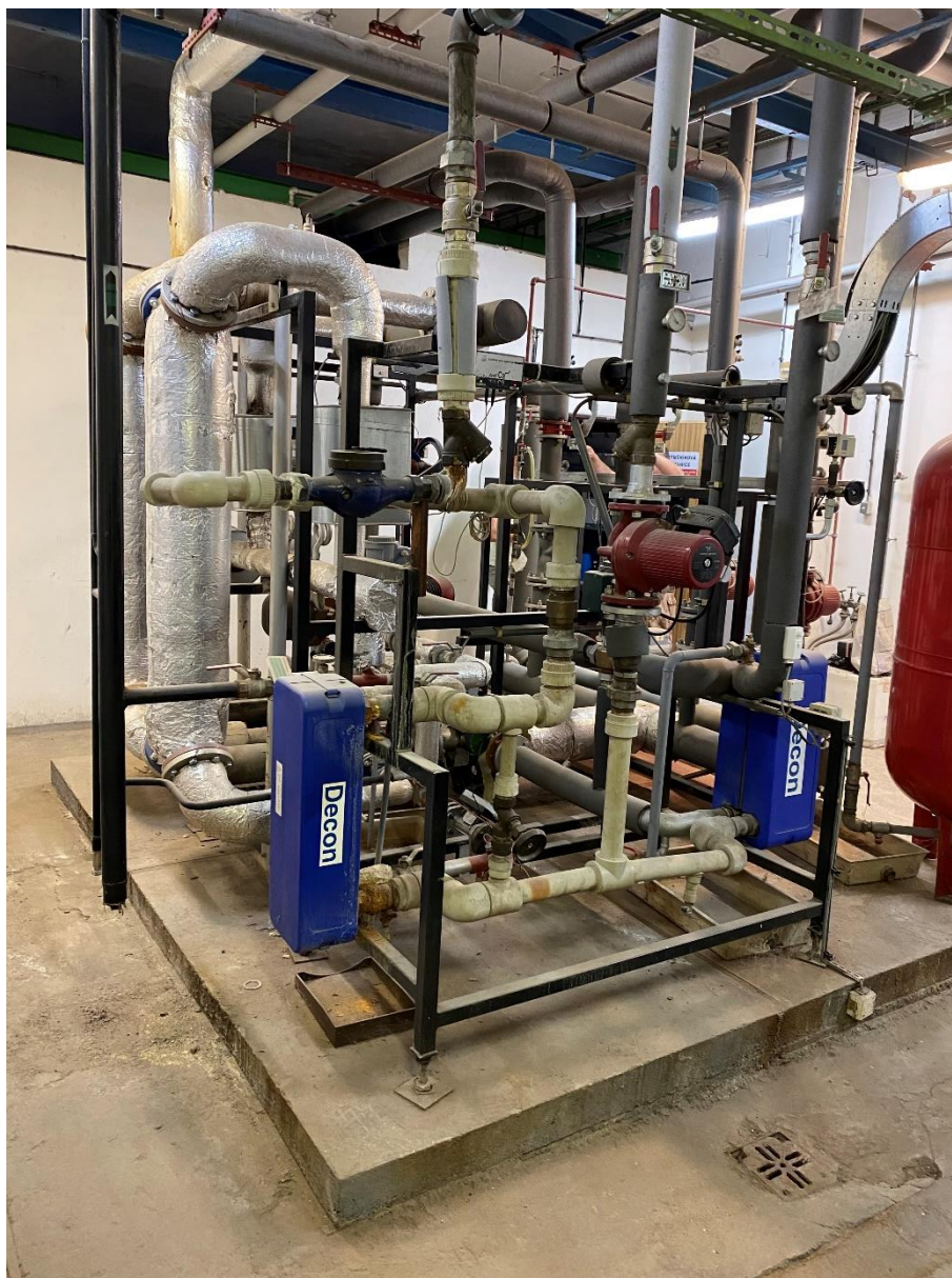
Obr. č. 4 – Hlavní výměníková stanice s přípravou teplé vody
